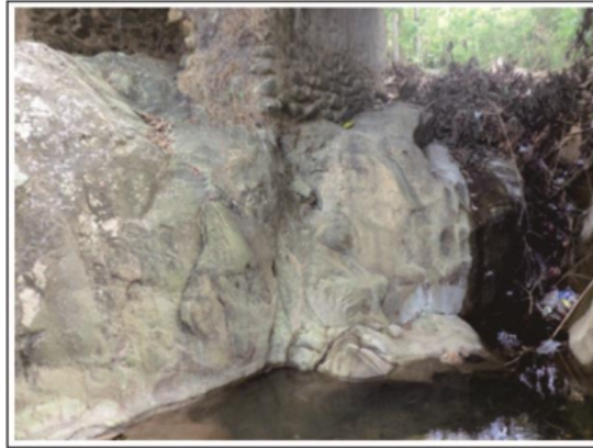
Gambar 3.26. Jalur sesar sinistral di bawah pondasi yang menjadi tempat munculnya air tanah pada musim kemarau.
