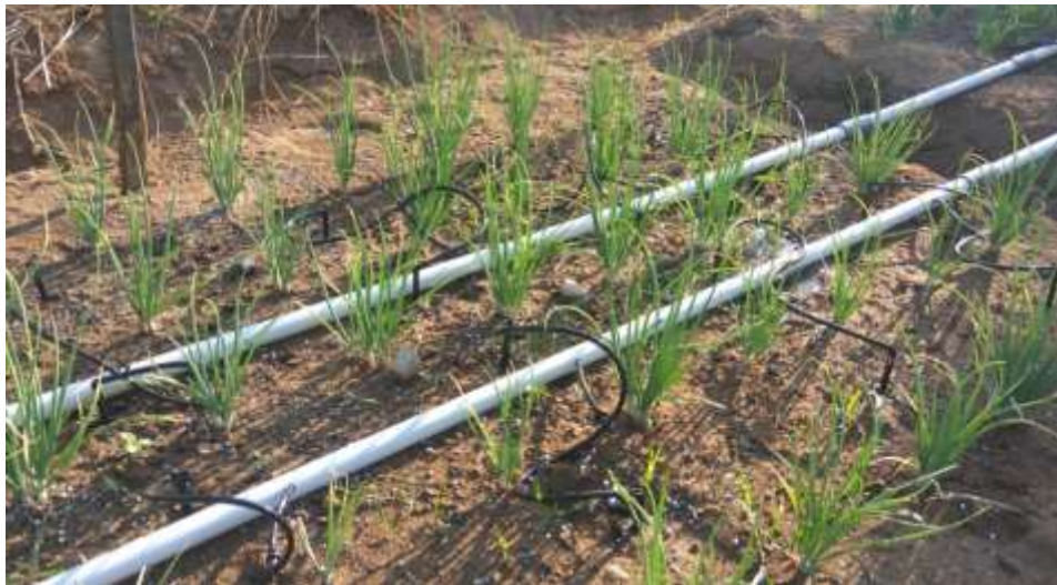
Gambar 7. Instalasi irigasi tetes menggunakan driper berdasar sensor kelembaban tanah
