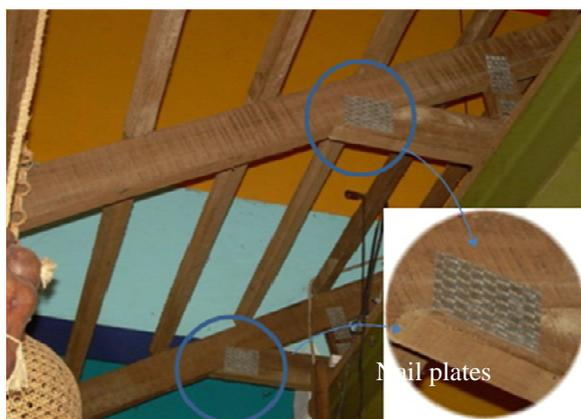
a) Rangka kayu dengan alat sambung *claw nail plates*
