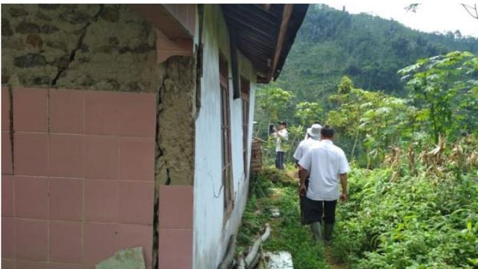
Gambar 8. Bangunan berat akan membebani lereng hingga tanah bergerak dan bangunan rusak.
