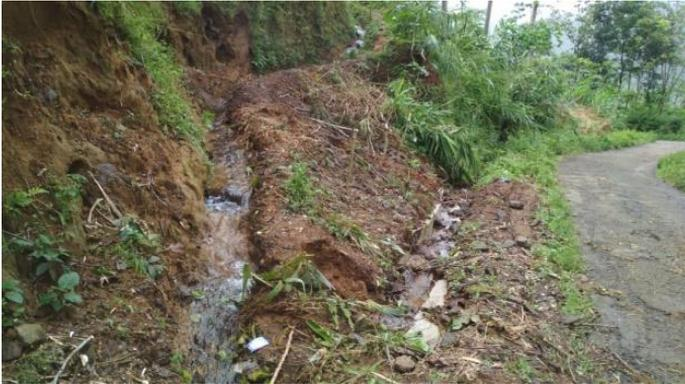
Gambar 7. Saluran irigasi yang dibuat pada lereng terjal meningkatkan resiko longsor.
